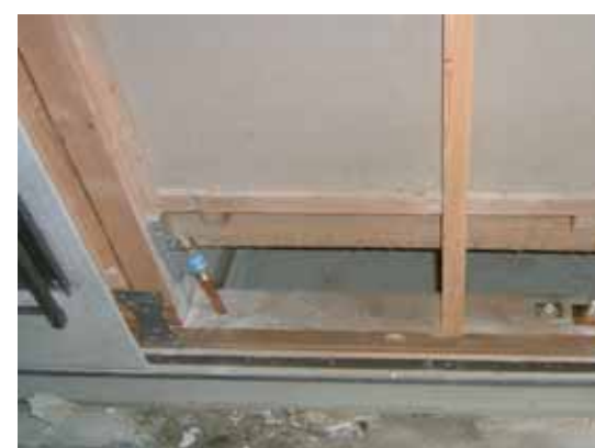
2. 外壁撤去、金物確認、補強
