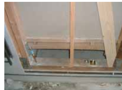
3. 接合金物設置
