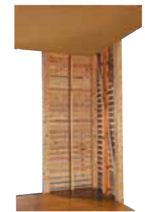
1. 既存仕上げ撤去
