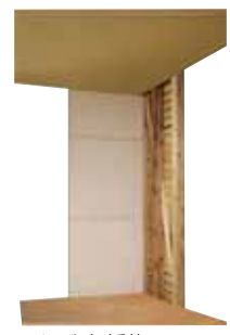
2. かべ大将施工
