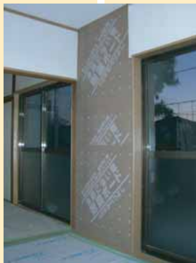
NEW かべつよし施工事例
