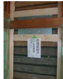
3. シールドプレート取付け
